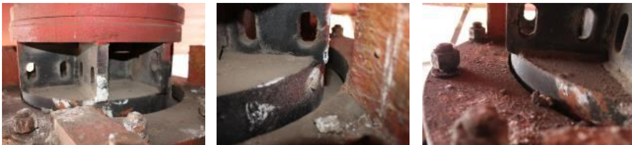
Figura 31 Dispositivo decentrato per effetto delle escursioni termiche
