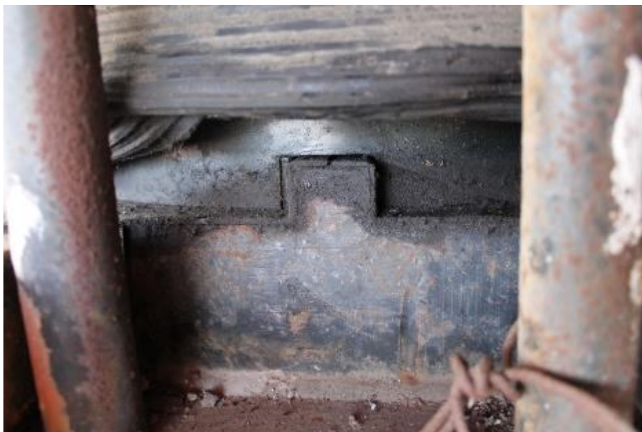
Figura 16 Vincolo carrello monodirezionale: binario
