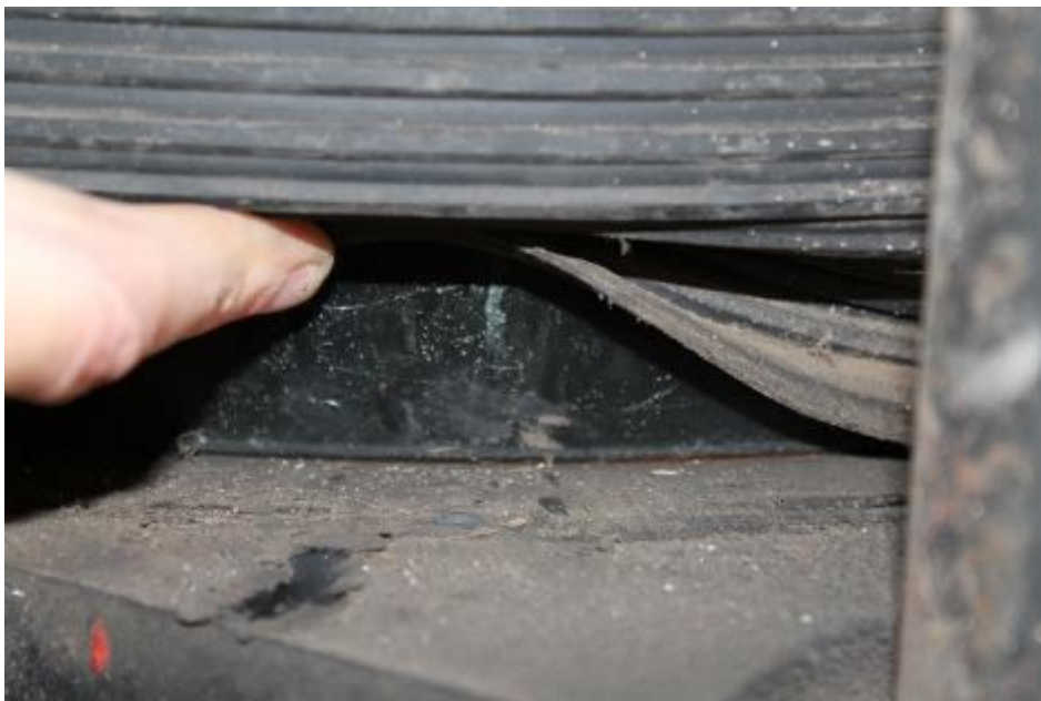
Figura 17 Vincolo cerniera fissa
