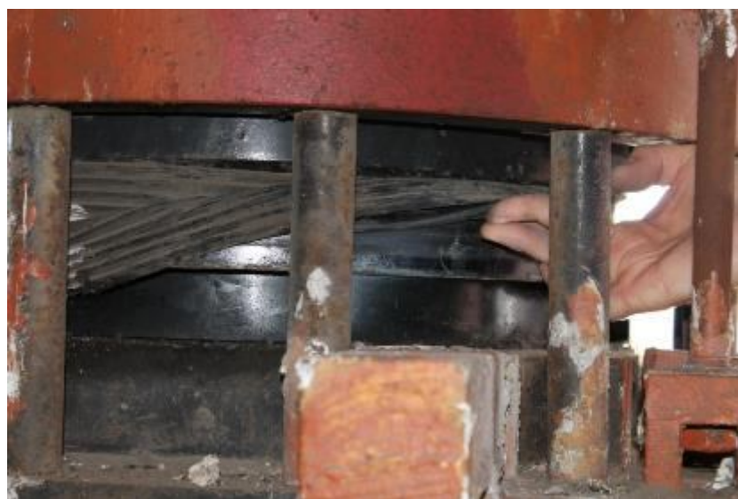
Figura 30 Carrello uni-direzionale ispezionato sul nucleo a sezione circolare
