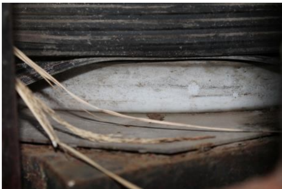
Figura 15 Vincolo carrello bidirezionale: superfici acciaio-teflon a contatto
