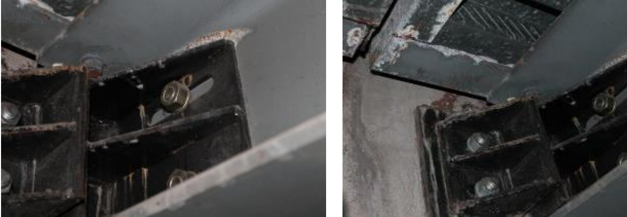
Figura 33 Asole di regolazione dei bulloni di ancoraggio in corrispondenza dei bumpers
