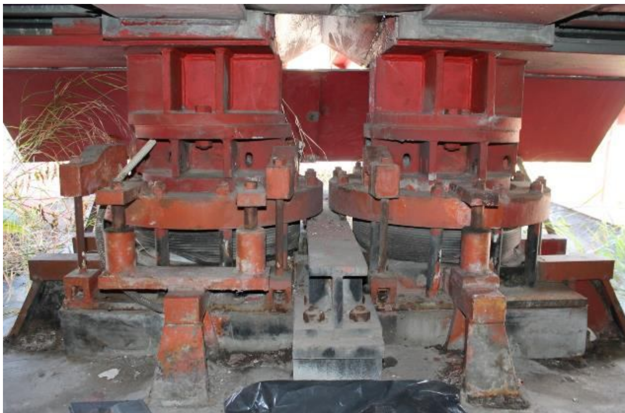
Figura 23 Appoggi accoppiati (modulo strutturale intermedio)
