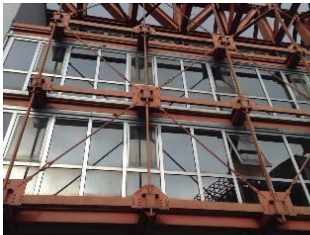
Figura 12 Particolare diagonalali di facciata.
