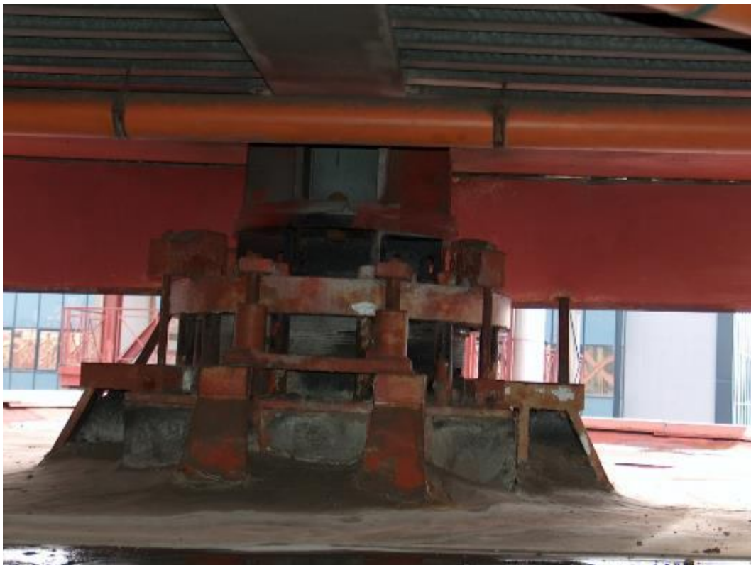
Figura 22 Appoggio singolo (modulo strutturale di estremità)
